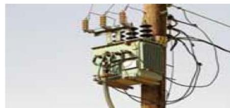
■ الشكل 15-6 تستخدم المحولات الخافضة للتقليل من الجهود الكهربائية الكبيرة في خطوط نقل القدرة إلى مستويات تناسب المستهلكين في أماكن الاستخدام.
