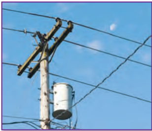
هناك أدوات تسمى المحولات تستعمل المغناطيسية لخفض التيار الكهربائي إلى قدر مناسب فيستخدم في المنازل.
