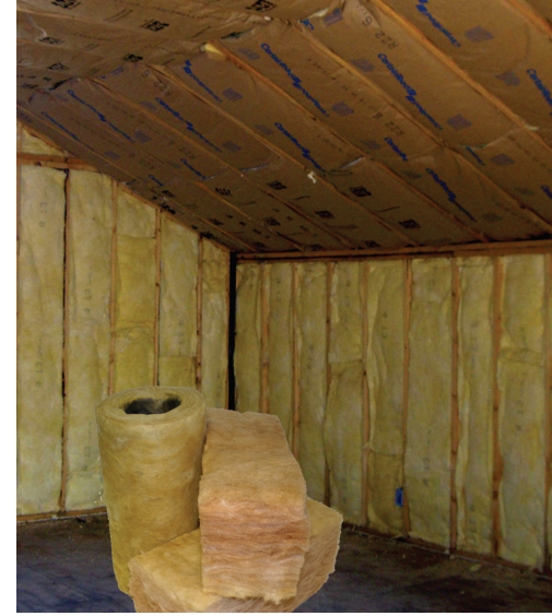
الشكل ٧ تعمل المواد العازلة في المنازل والبنائيات على التقليل من انتقال الطاقة الحرارية بين الهواء داخل المنزل والهواء خارجه.
