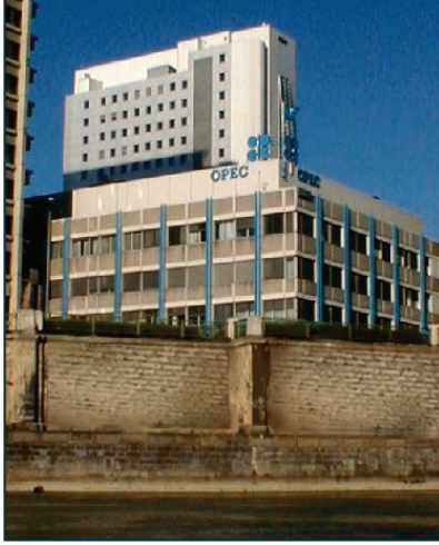
مبنى منظمة أوبك في فيينا
